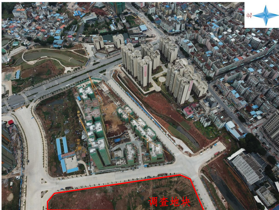
图 2.5-4 地块外东侧航拍图（航拍于 2022 年 12 月 04 日）
