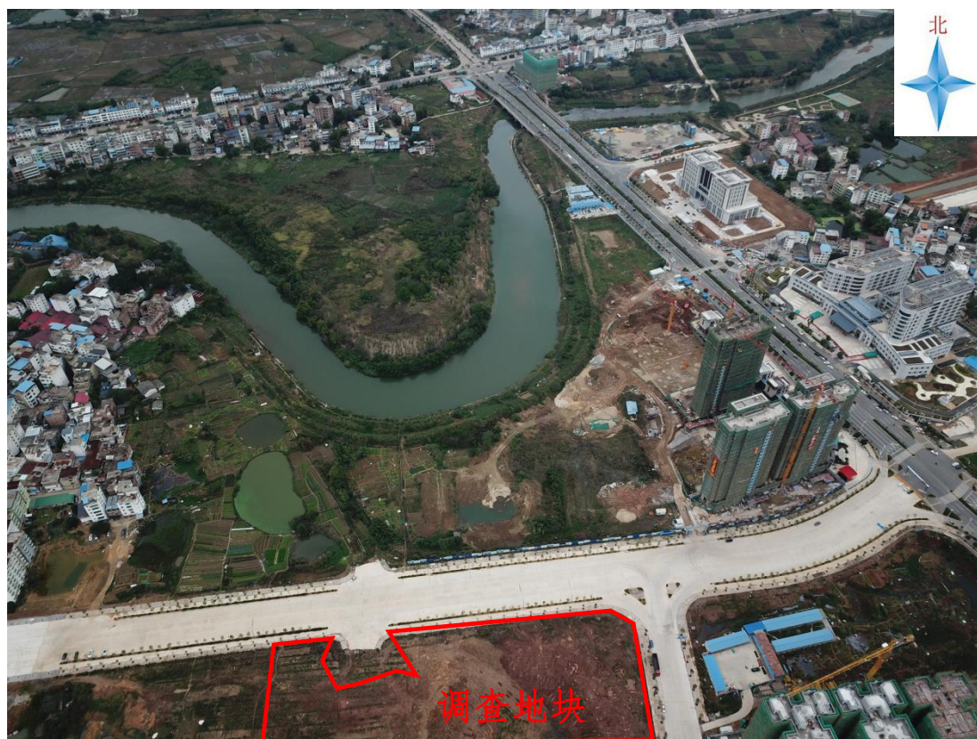
图 2.5-1 地块外北侧航拍图（航拍于 2022 年 12 月 04 日）
