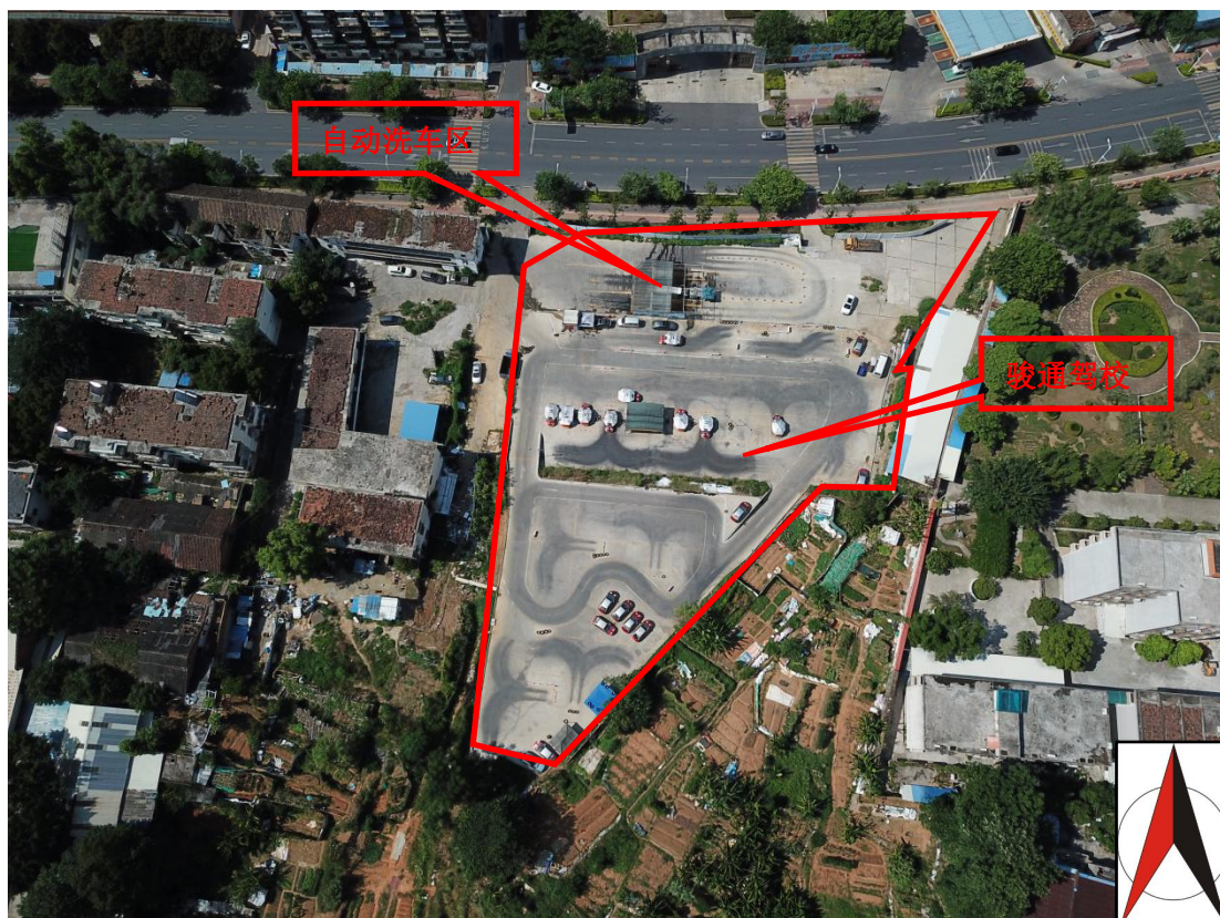
图 2.4-2 本地块现状航拍图（拍摄日期为 2022 年 8 月 22 日）
