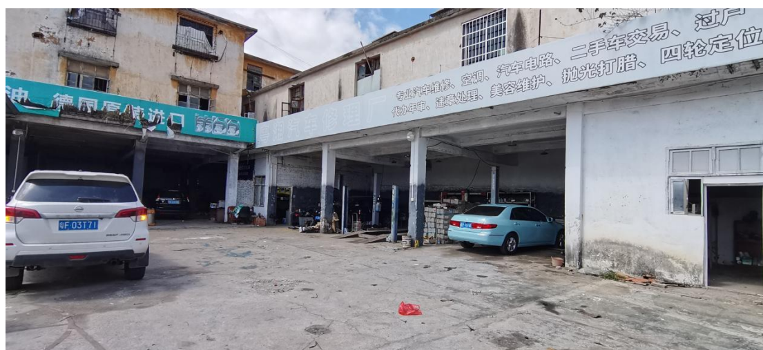
图3.2-1 粤湘汽车修理厂现状图（拍摄于2022年8月22日）
