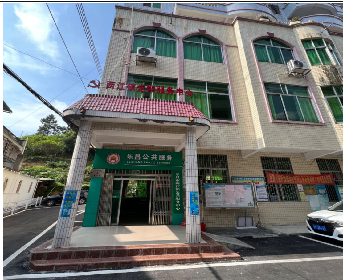
党群服务中心，地面已硬化（镜头朝西北，拍摄时间：2023.9.27）
