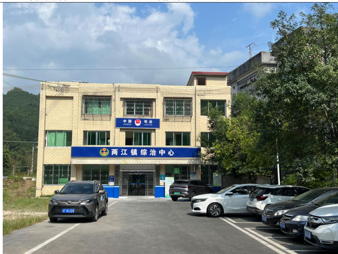
两江镇综治中心，地面已硬化（镜头朝东方向，拍摄时间：2023.9.27）
