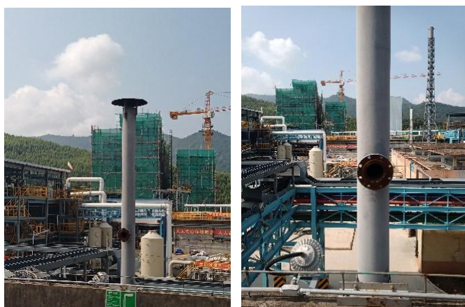
⑨MVR 蒸盐废气排放口 (DA009)
