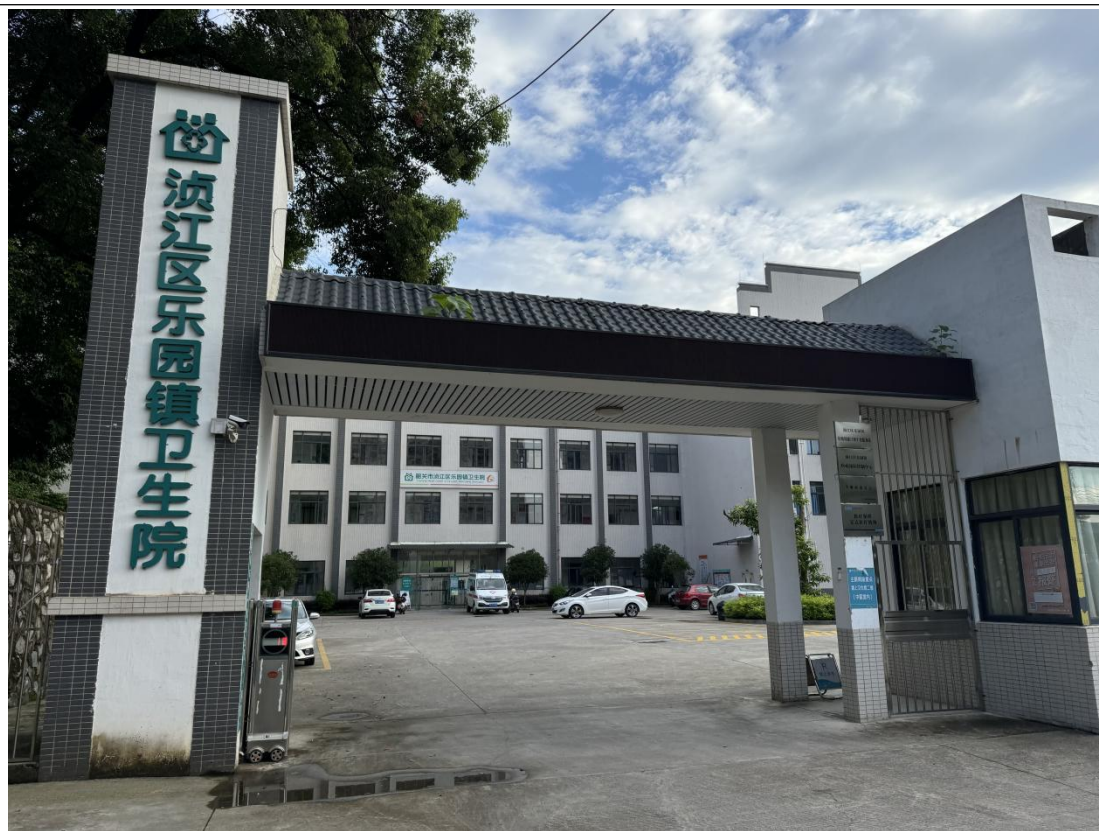
卫生院大门（镜头朝南，拍摄时间：2024.6.13）
