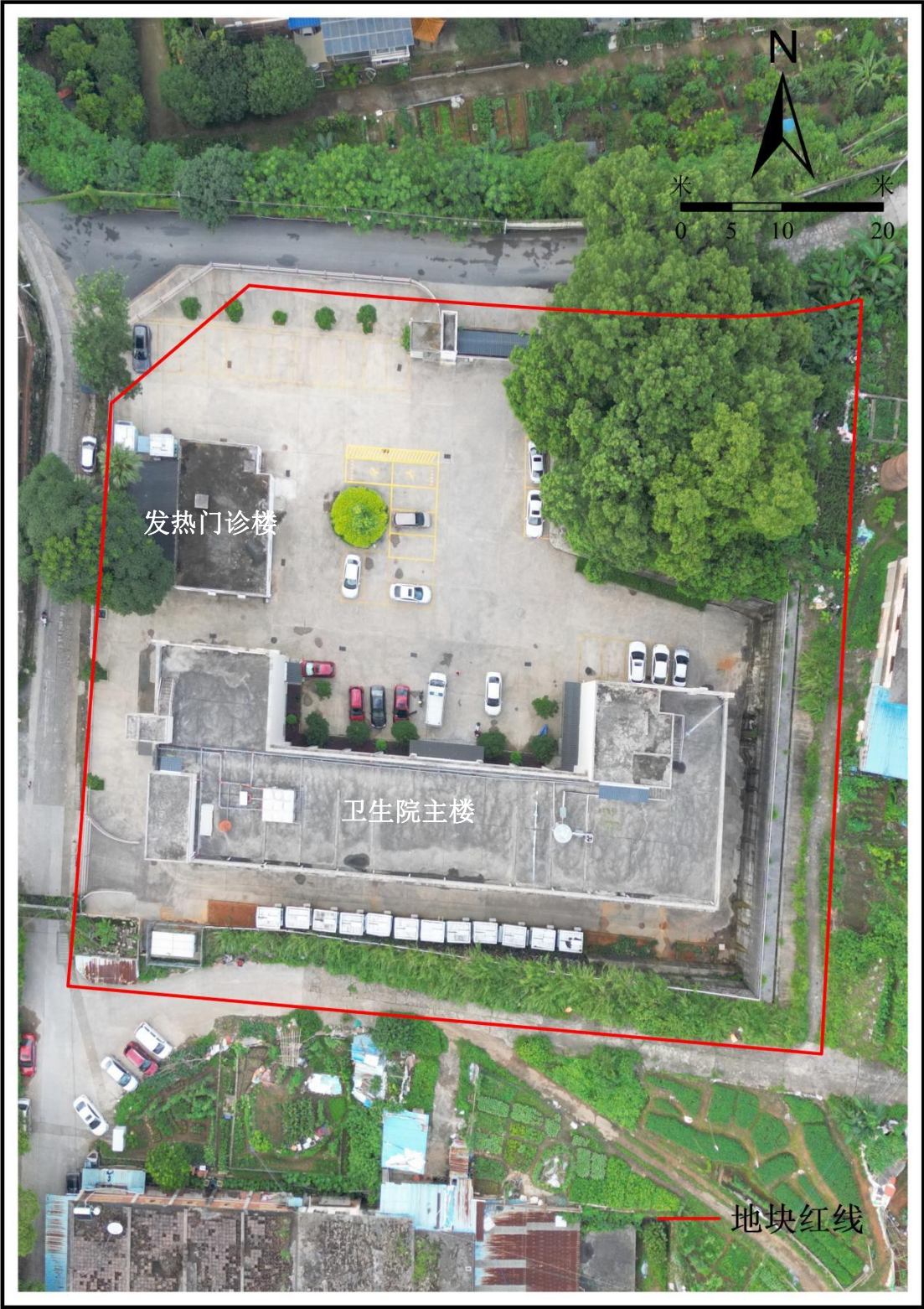
图 3.3-1 地块现状航拍图（拍摄时间：2024.6.13）
