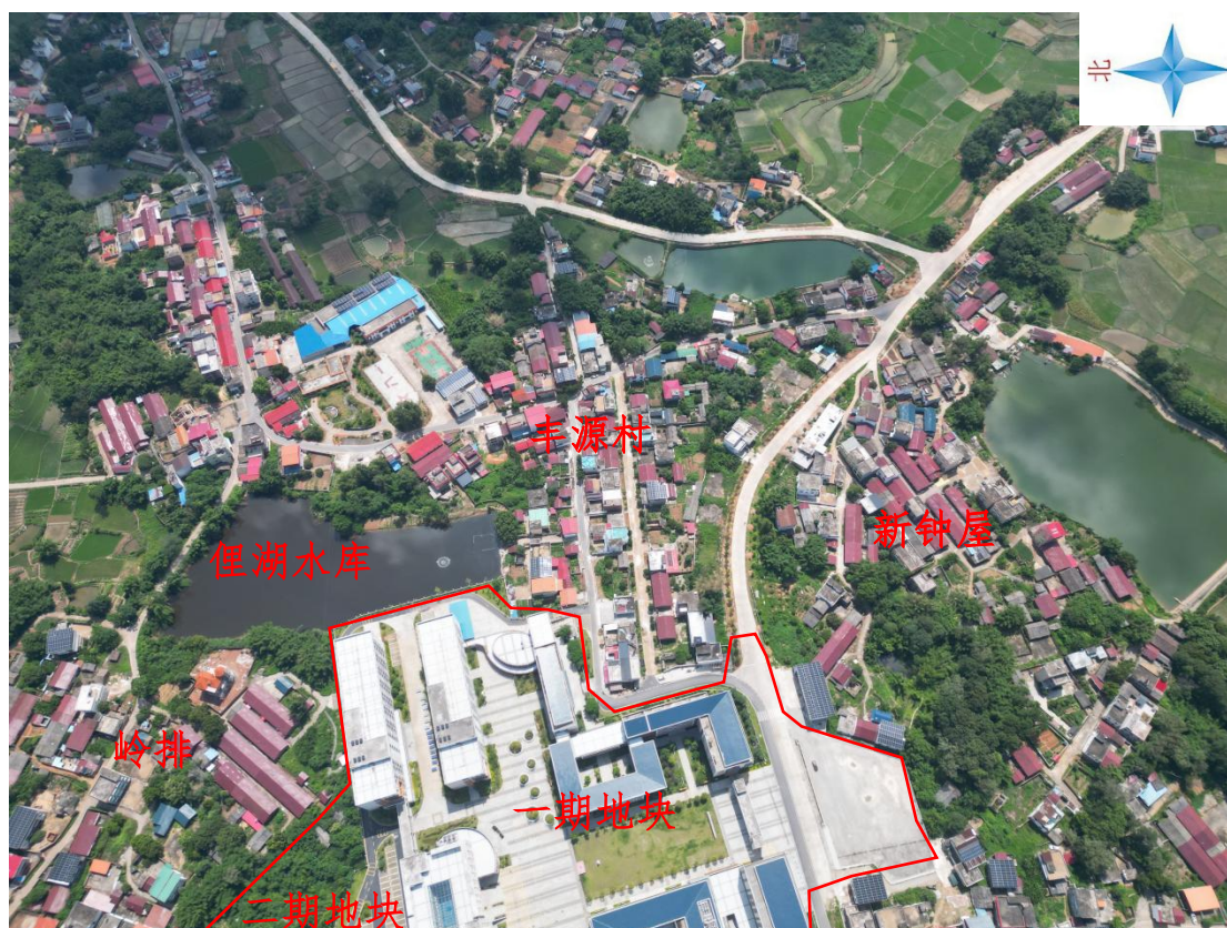
图 2.5-4 调查地块外东侧航拍图（航拍于 2025 年 8 月 12 日）
