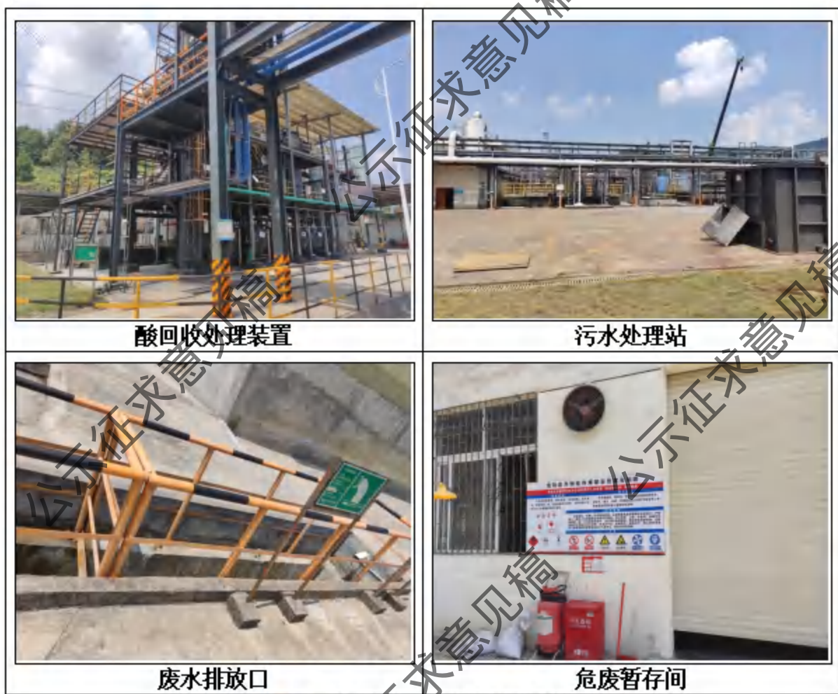
图 3.1-3 现有项目部分设施现状照片
